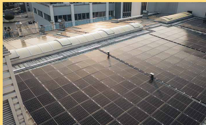
Über 1.800 Photovoltaik-Module wurden auf den Dächern der Backstuben installiert.
